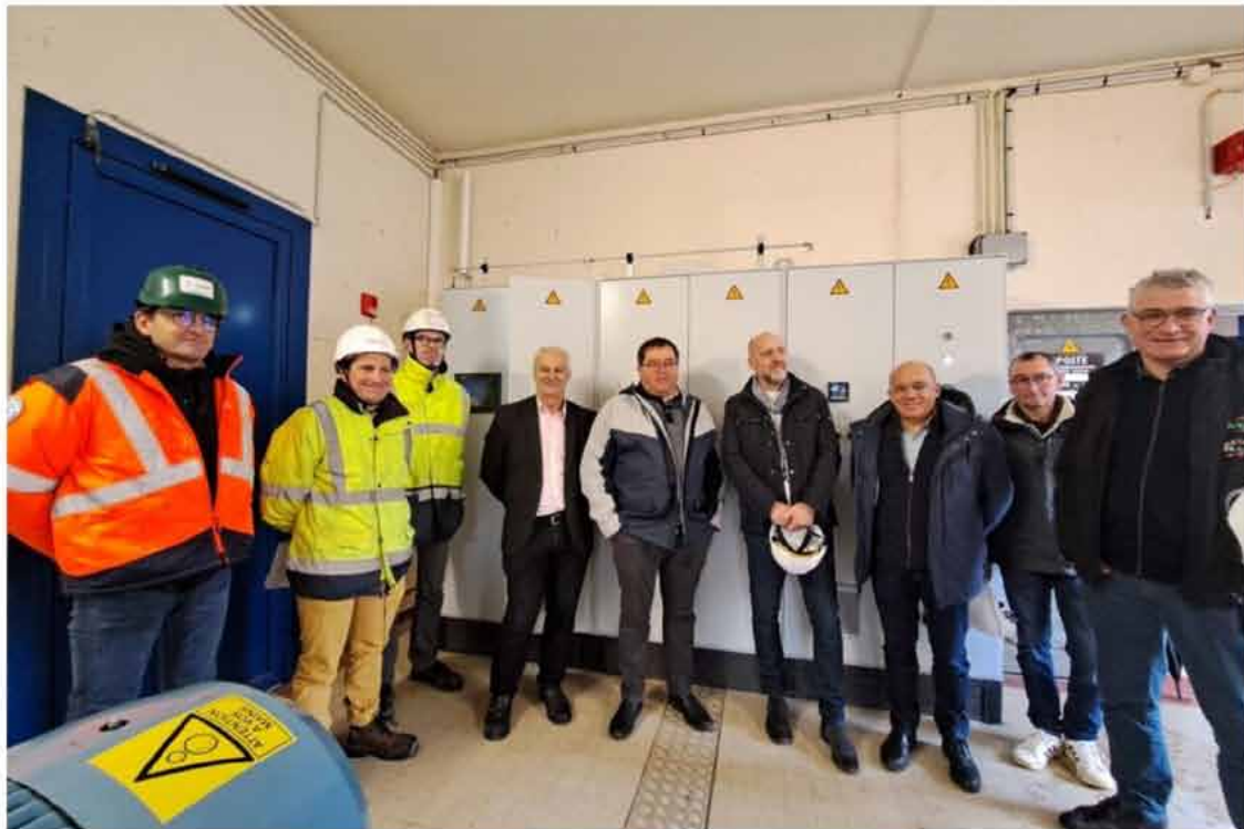
Élus et techniciens dans la salle de pompage de l'usine de Trigodet ©Patricia BIGOT
