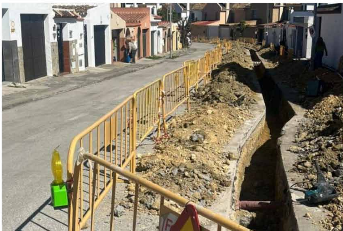
Avanzan las obras en la calle Trucha.
