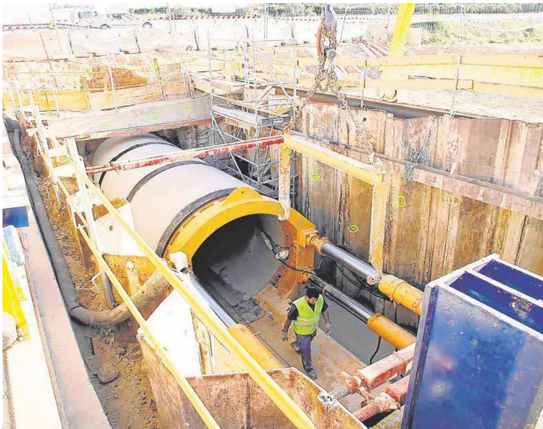
Obras del trasvase Júcar-Vinalopó. IRENE MARSILLA
